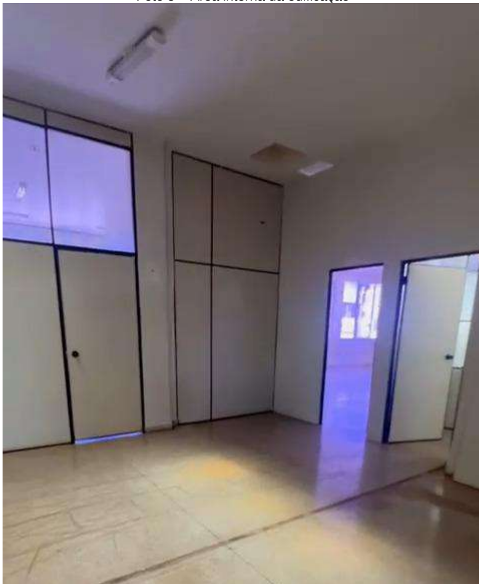
Foto 5 – Área interna da edificação
