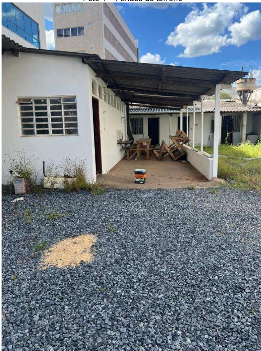
Foto 4 – Fundos do terreno
